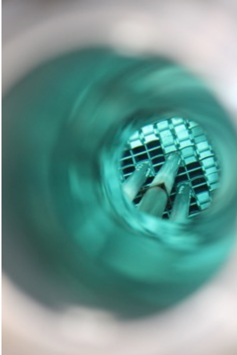
写真1. 原子炉の上の覗き窓。
