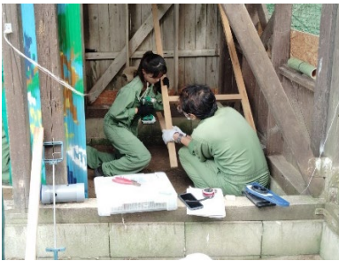
カラスの滑り台設置
